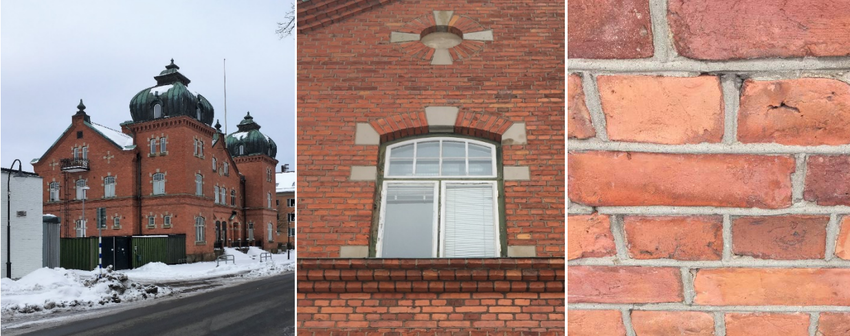
Figur 2. Vy från Norra Kungsvägen över byggnadens huvudentré, samt detaljer på fönsteromfattningar och tegelfasaden med rundfog.
