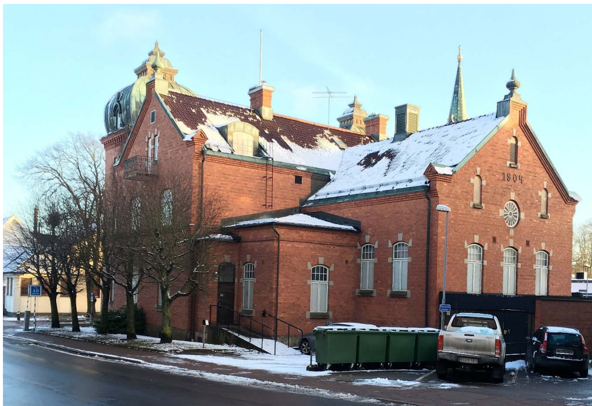
Figur 1. Vy av byggnaden från Rådhusgatan där gördel- och takgesimser, rosettfönster samt trädallén syns.
