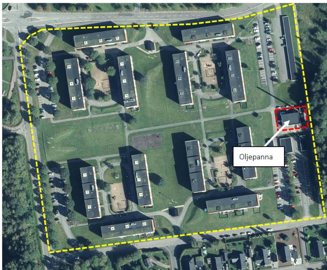
Figur 1. Gul markering visar fastigheten Stensiken 1. Röd markering visar lokaliseringen av oljepannan kring vilken markundersökningen utfördes.
