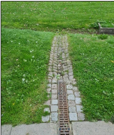
Figur 9.6 Exempelbild på ränna för avvattning till parkmiljö
