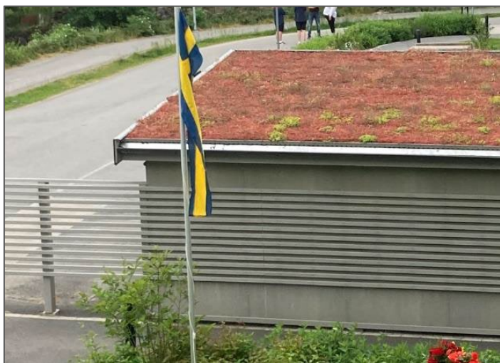
Figur 9.9 Exempelbild vegetationsklätt tak.
