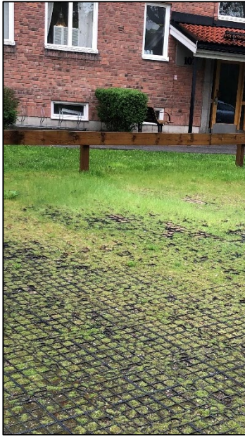
Figur 9.10 Exempelbild genomsläpplig beläggning.
